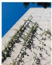
Grimpantes sur treille de câbles, avenue Courcelles, programme S. 0003e, Paris 15 e . La grimpante de câble disparaît-elle sous le couvert végétal ?
