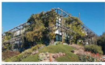
Le bâtiment des services de la qualité de l'air à Santa Barbara, Californie. Les façades sont constituées par pergolas et des bras-solés câbles qui constituent une structure support en trois dimensions pour les grimpantes.
